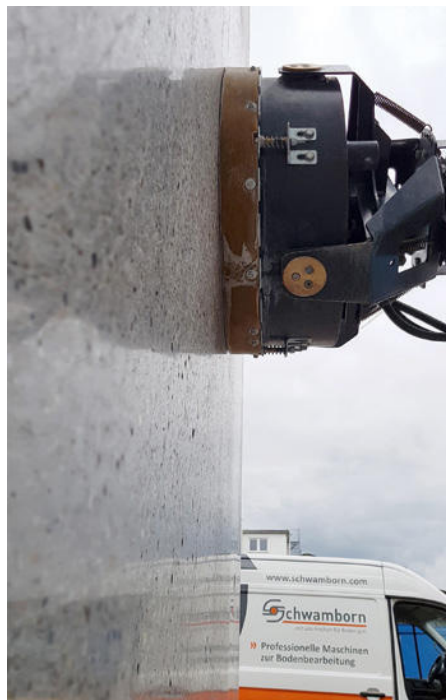
Beton polieren: Auch bei Neigungen bis zu 6% liegt der Schleifkopf immer plan auf.
