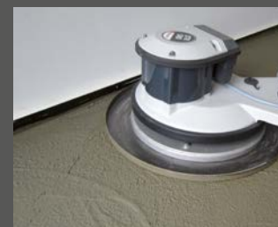
Заглаживание бесшовного пола
